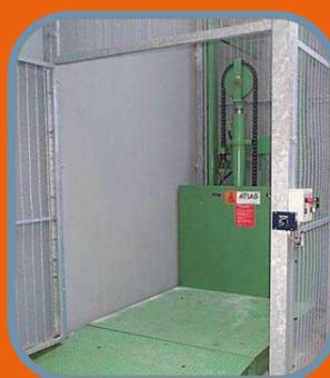
**Implantation :** Pour accéder au plateau, l'élévateur à simple ou double colonnes nécessite une fosse peu profonde, ce qui réduit les frais de génie civil ou peut être posé à même le sol et équipé, dans ce cas, d'une petite rampe d'accès.
